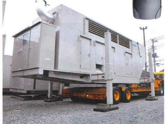
発電設備には自揚システム（前後につけられた4本の脚が設備の上下動を行う。リモコン操作可）が装備され、効率よく安全に設置できるような工夫が施されている。
