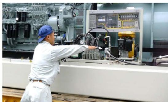
写真8 自揚制御装置と機側操作
